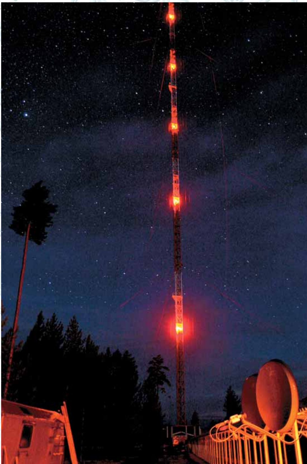
Мачта высотой 302 м новой научной станции Института леса им. В. Н. Сукачева СО РАН (Красноярск). Фото М. Хильшера
