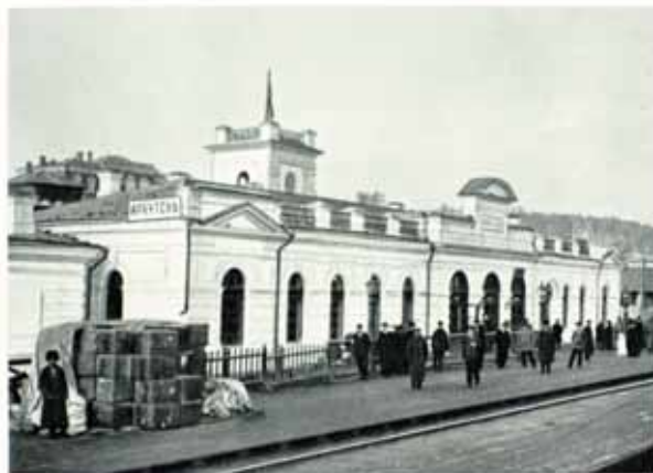
Типичное станционное здание на Сибирской жел. дор.
