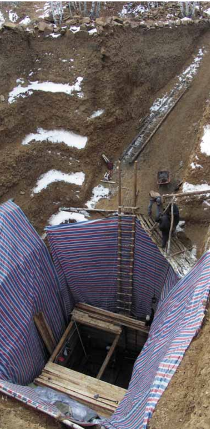
На дне раскопа для безопасности и в связи с началом «снежного» сезона сооружен сруб из бруса, в котором и ведутся все работы. Стены задранированы, чтобы предотвратить осыпание грунта. Ноябрь, глубина раскопа 18 м 38 см
